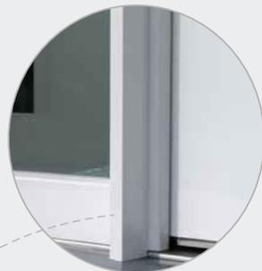
Bei Haustüren mit Seitenteil muss gewährleistet sein, dass der schwere Türflügel satt ins Schloss fällt. Fallweise wird deshalb ein stabiles Statikprofil auf den Pfosten montiert.
