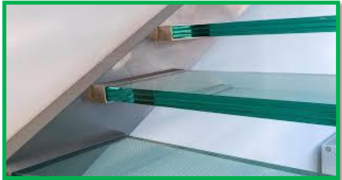
Treppenstufen aus VSG
